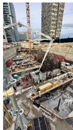
aktueller Blick in die Baugrube
