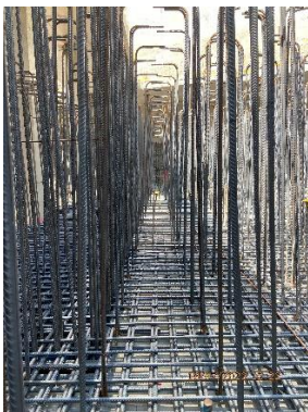
Mannshohe Bewehrung der Bodenplatte
